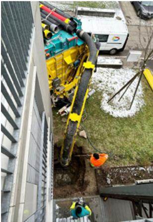
Saugbagger zum Einsatz, der zwar laut, dafür aber in kürzester Zeit ein Loch bis zur Wasserleitung «gesaugt» hatte. Da zu vermuten war, dass die zweite Einführung ebenfalls in einem schlechten Zustand sein könnte, hat man dann in der Folge auch die zweite Einführung gleich saniert.
