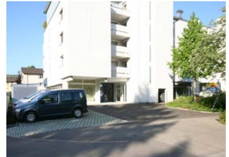
Bei der Renovation und dem Umbau der Alterssiedlung Roswiesenstrasse 176/178 im Jahre 1998 wurde die Fassade eingepackt, die Balkonbrüstungen mit ihren markanten Betonstrukturen wurden belassen respektive soweit nötig repariert. Leider bröckelten diese Betonstrukturen in den letzten Jahren erneut und das Ganze wird nun wieder unansehnlich. Wir haben von Oppliger Architekten AG einen Vorschlag mit Glasbrüstungen ausarbeiten lassen. Dieser wird voraussichtlich im Jahre 2009 realisiert werden.
