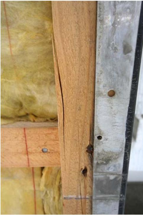
Die Schrauben sitzen teilweise falsch oder locker in der Unterkonstruktion.
