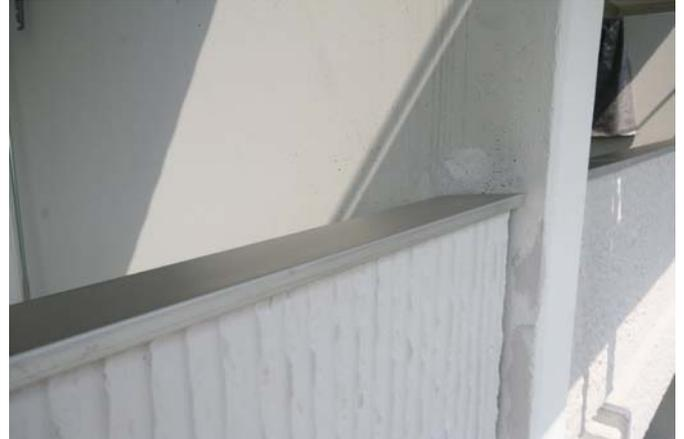
*Die Betonstrukturen wurden wiederhergestellt und mit Chromstahlabdeckungen versehen*
