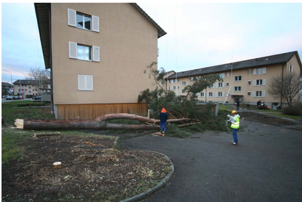
Bei der Rodung für den Neubau Luegisland Süd packen unsere Mitarbeiter zu
