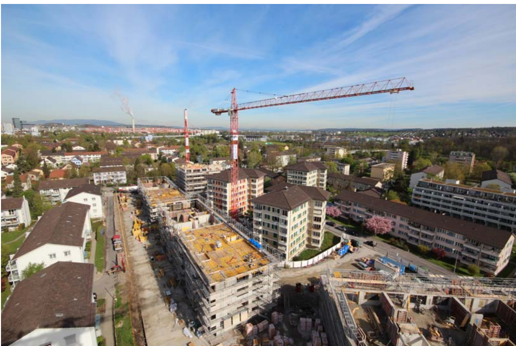
Baustelle Luegisland Süd, Ende April 2012, vom Kran aus gesehen
