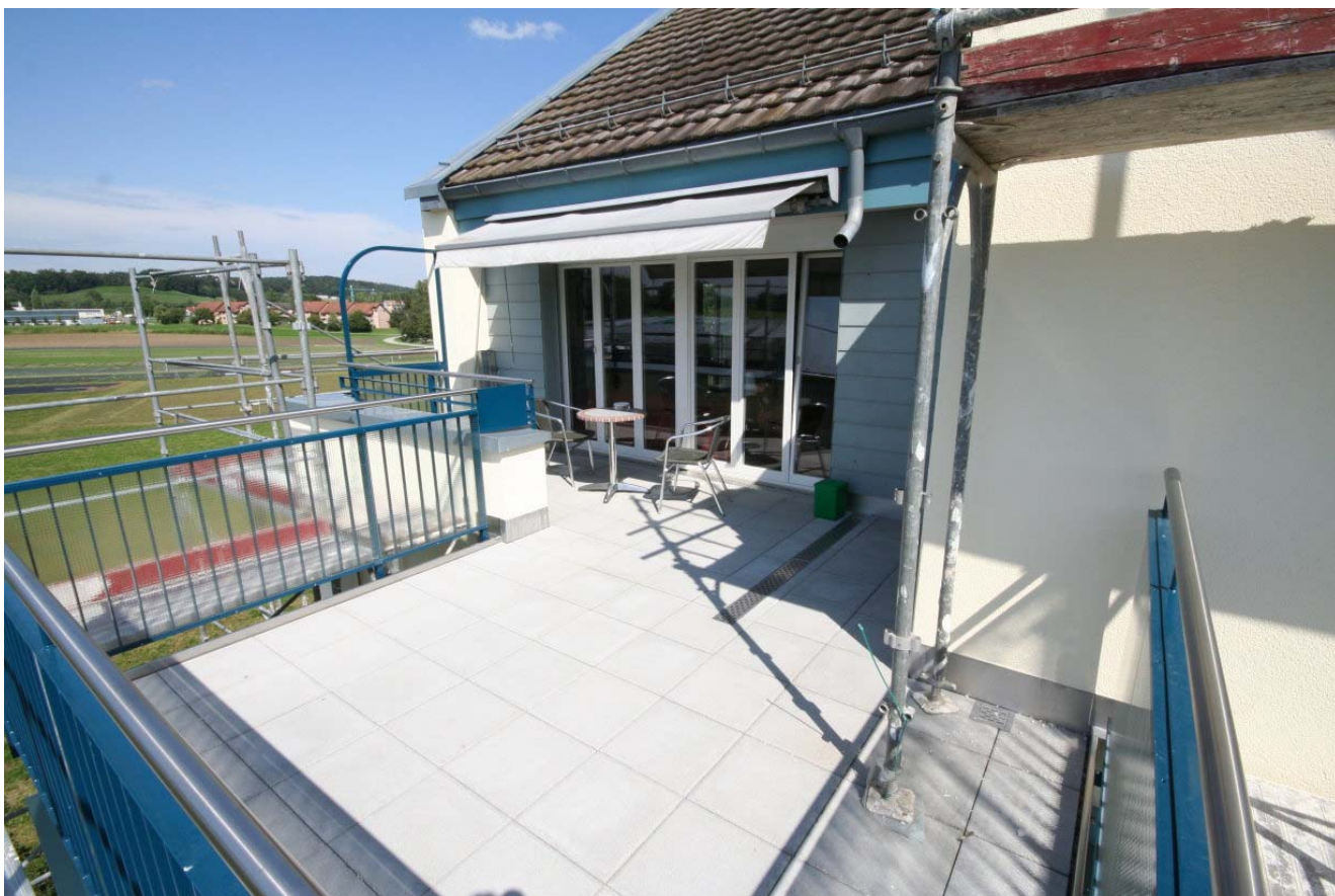
Balkonerweiterung Dachwohnungen Wiesenstrasse in Schwerzenbach
