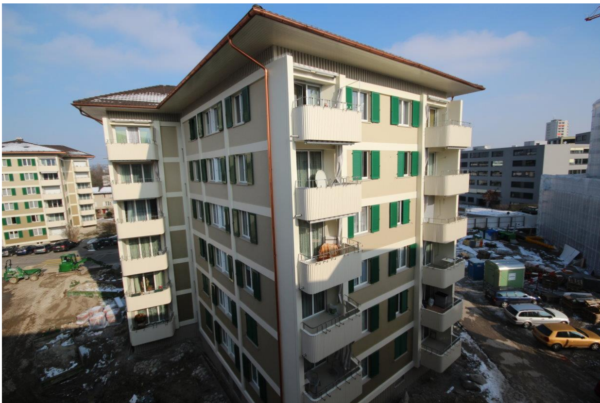
Das fertig renovierte Hochhaus inmitten des Neubaus Luegisland Süd
