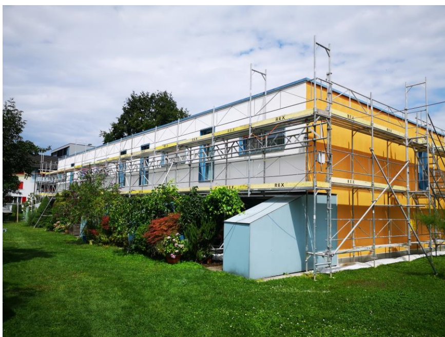
Fassadenarbeiten EFH-Siedlung Kronwiesen
