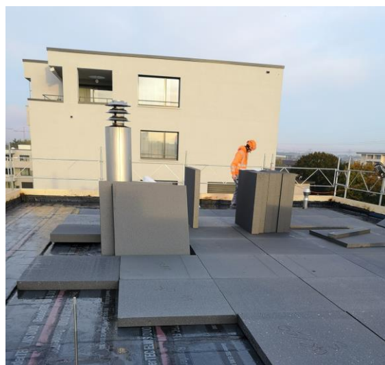
Das Dach der Alterssiedlung Roswiesenstrasse 176/178 wird isoliert.
