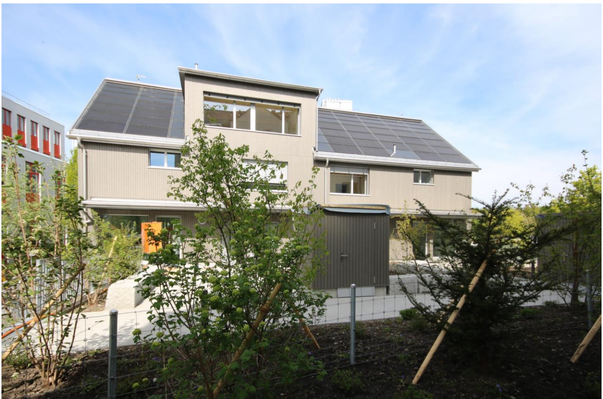
Das neue Doppel-EFH in Schwerzenbach
